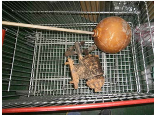
圖一 損壞之浮球開關
